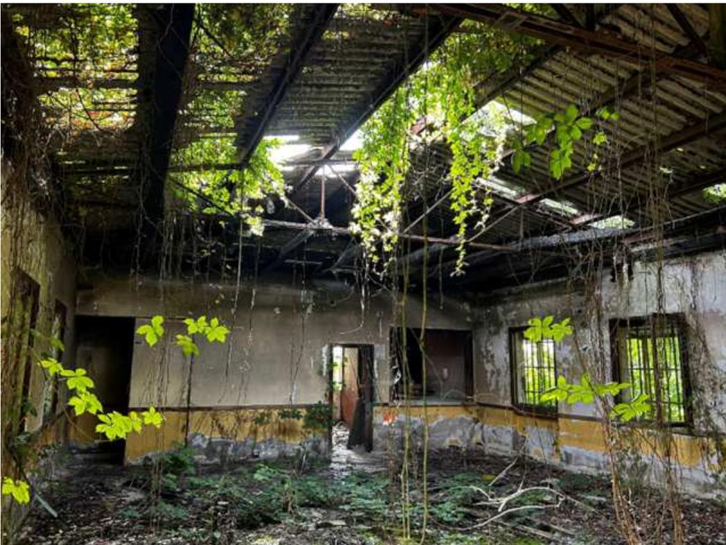
*Figura 3: Interno del ristorante. Si noti il soffitto in Eternit sbriciolato in più punti e le travi carbonizzate. Dopo dieci anni circa di abbandono la vegetazione ha completamente ricoperto il fabbricato.*
