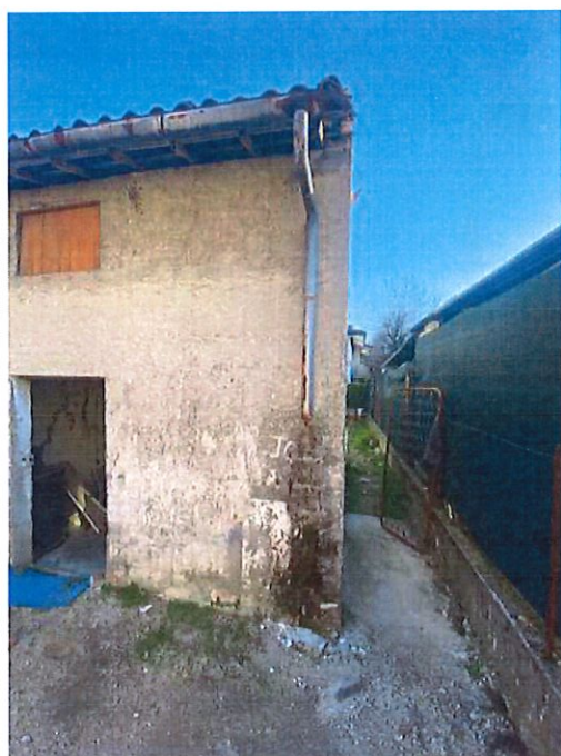
Deposito piano terra
