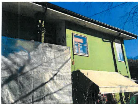
Vista Piano primo
