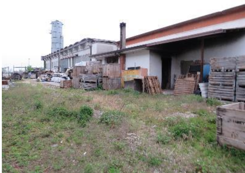
Vista Sud Est
