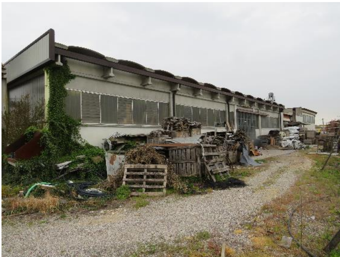
Vista Sud Ovest
