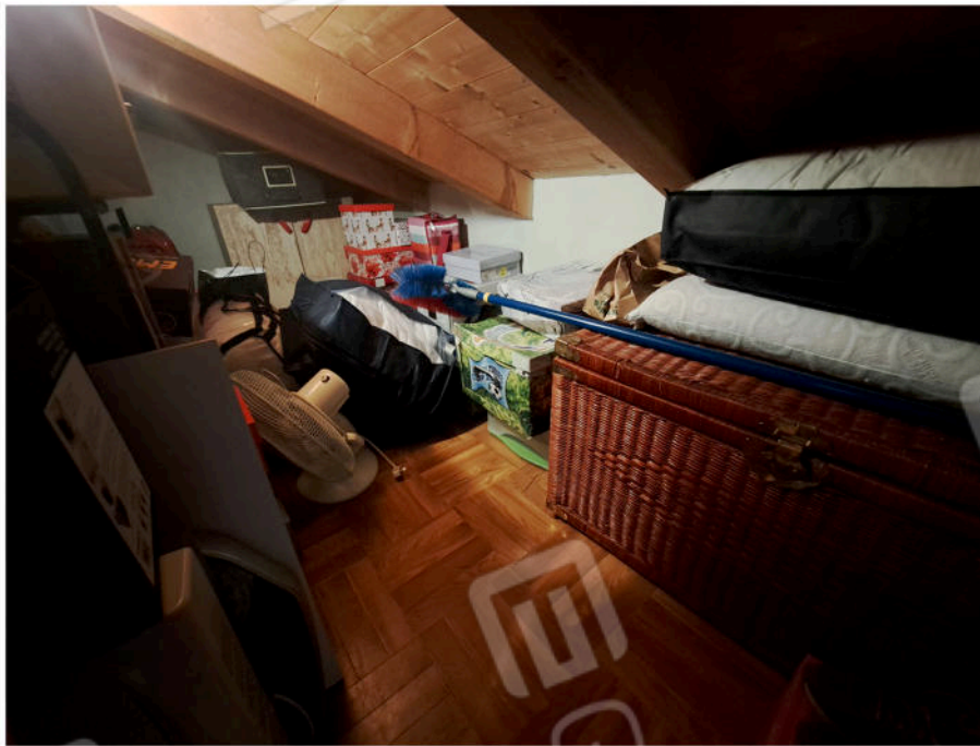
09 vista interna della soffitta P2
