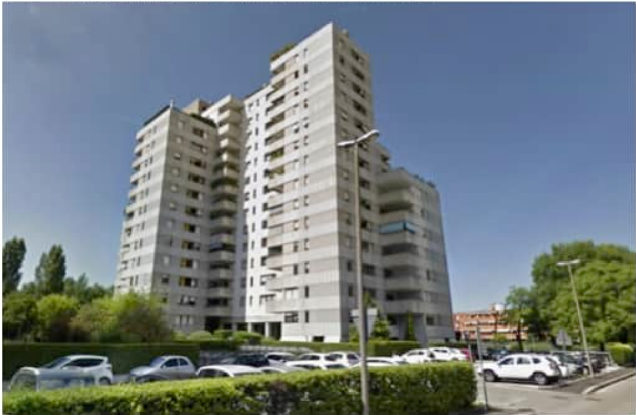
FOTO - INQUADRAMENTO IMMOBILE OGGETTO D'INTERVENTO
