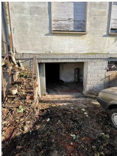
Entrata al garage
