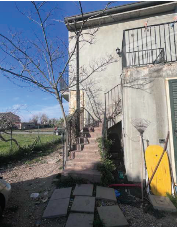
FOTO 6 - Scala di accesso unità prospetto Sud
