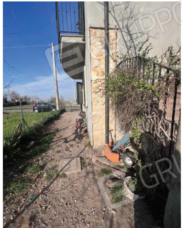
FOTO 5 - Passaggio carraio prospetto Ovest
