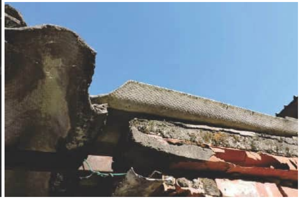
Foto 22 Lastre di copertura in cemento amianto
