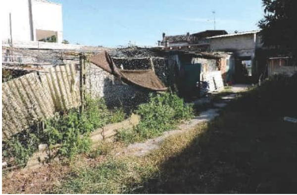
Foto 20 e 21 Viste dei depositi dall'area cortiva esterna
