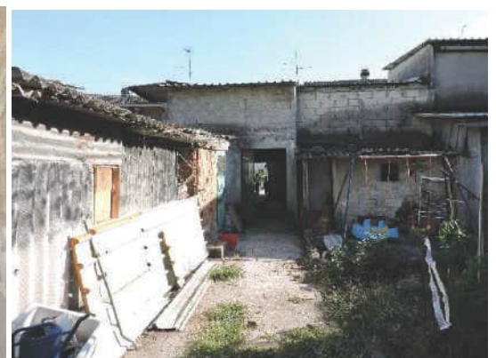
Foto 20 Viste dei depositi dall'area cortiva esterna
