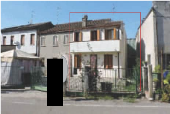
Foto 1 Fronte principale abitazione Part. 283/1
