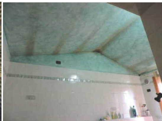
Foto 17 Soffitto del bagno con fenomeni di muffa
