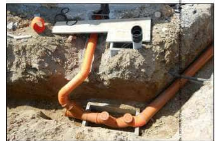
FOTO 3 - pozzetto allorcola di ispezione Ipo-Tiersee e hitrazioni di collegamento alla fognatura pubblica
