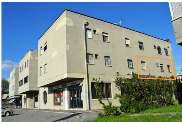
foto 1 - vista da sud ovest del condominio EX GRATTACIELO sul m.n. 1381 col piano terra a destinazione commerciale o terziaria e i piani 1° e 2° a destinazione residenziale. In primo piano a sinistra della foto la via Montanara con l'ingresso condominiale al civ. 4 al centro dell'edificio
