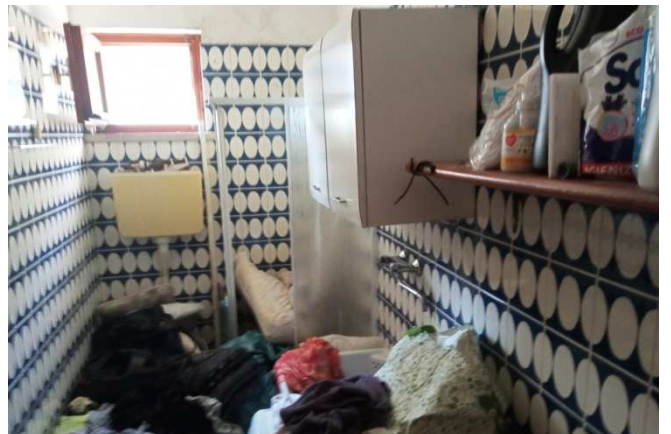
foto 18 - Scorcio interno del W.C. e lavanderia
