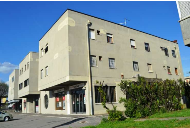
foto 5 - L'angolo sud ovest del condominio
