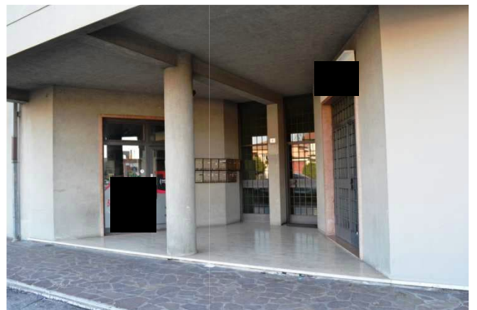
foto 8 - L'ingresso condominiale in via Montanara n. 4
