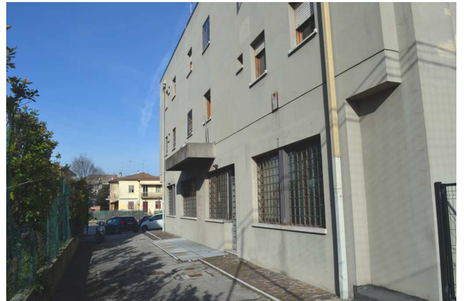
foto 6 - Vista da sud est del fianco sud dell'edificio
