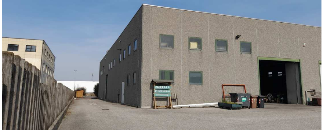
Foto 3 - Capannone con lato dx - Vista da via Staffali
