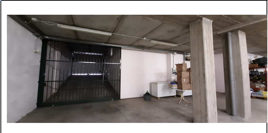
Foto 8 - Ingresso rampa Magazzino
