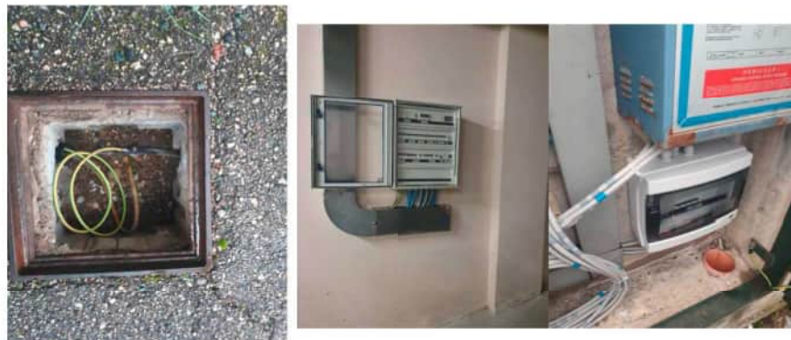
Foto 5 - Posa Massa a terra e nuovo contatore
