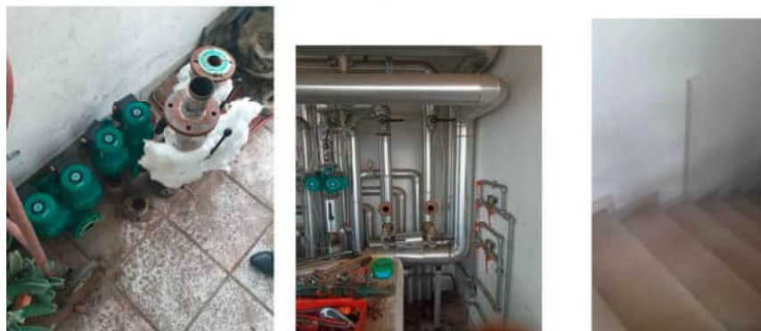
Foto 6 - Scollegamento impianto termico della capannone dalla CT
