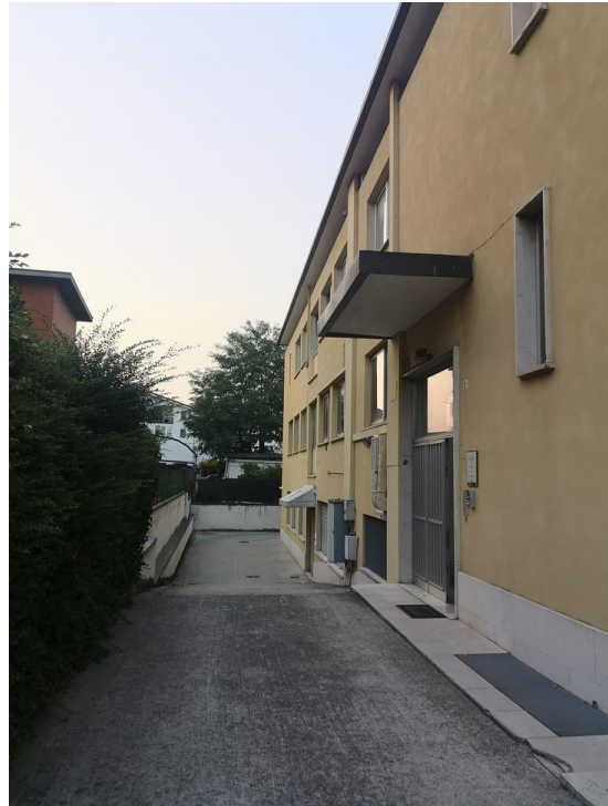
fronte laterale interno – lato Ovest
