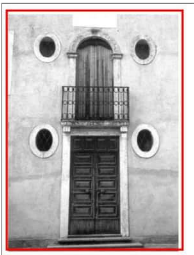
Particolare del partito centrale del fronte della casa del gastaldo (Archivio IRVV)
