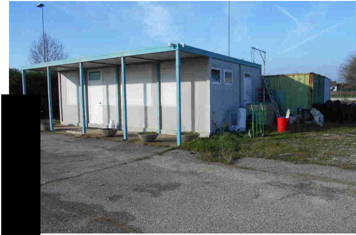
Vista edificio ad uffici con container sul retro
