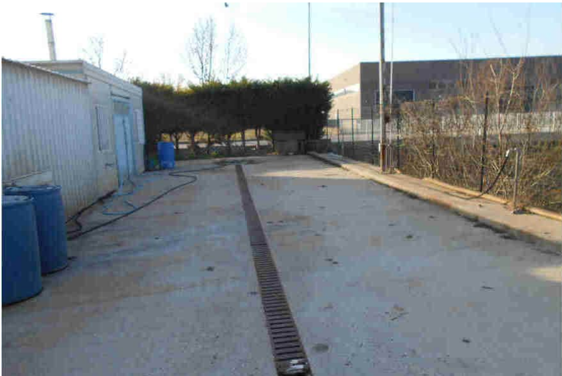
vista area lavaggio automezzi con manufatti prefabbricati
