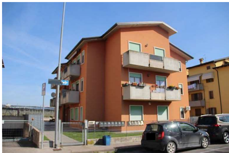
Facciata su Via dei Poeti
