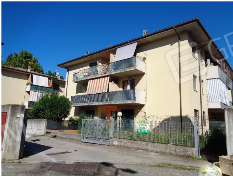
Edificio in Via Udine, n. 52/A – San Bonifacio (Vr)
