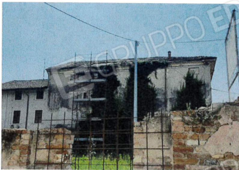
1. Facciata laterale fg. 8 mapp. 323 sub 1
