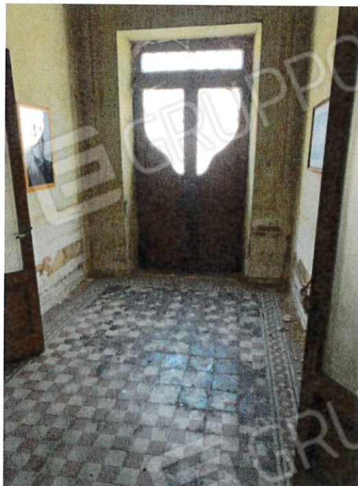
7. Ingresso – p.t. (fg 8. Mapp. 323 sub 1)
