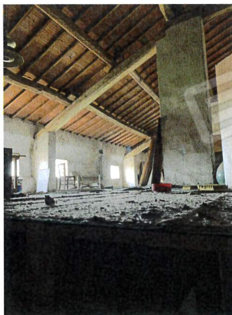
34. Soffitta - p. 2 (mapp. 929)
