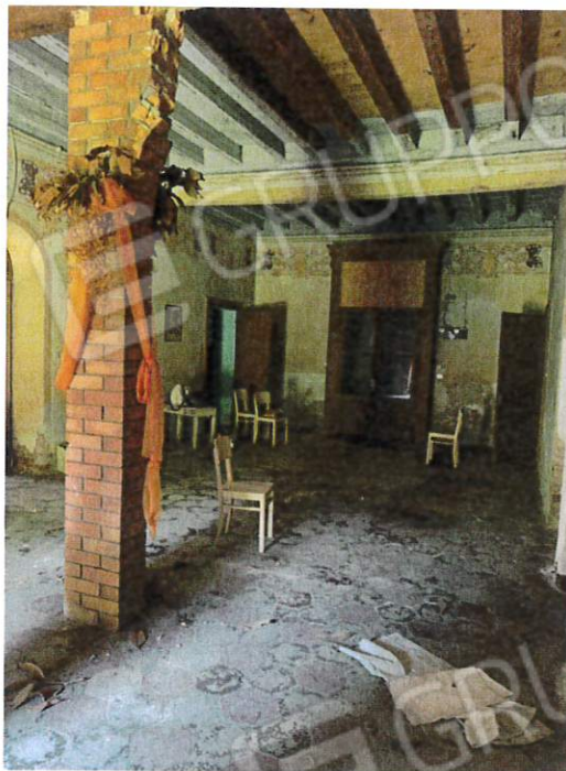
11. Locale sala in cui è stato demolito il divisorio tra le due unità - p.t. (fg 8. Mapp. 323 sub 1)
