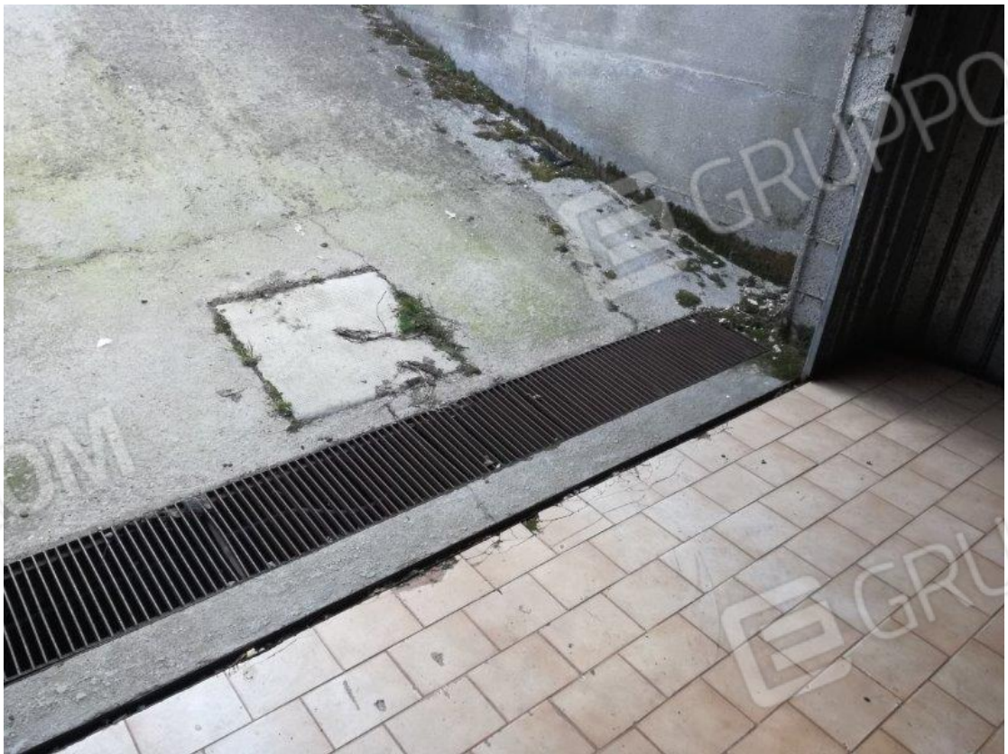
Foto 10: griglia e pozzetto perdente
