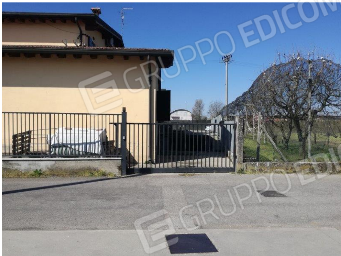
Foto 19: vista ingresso da via Zambonina
