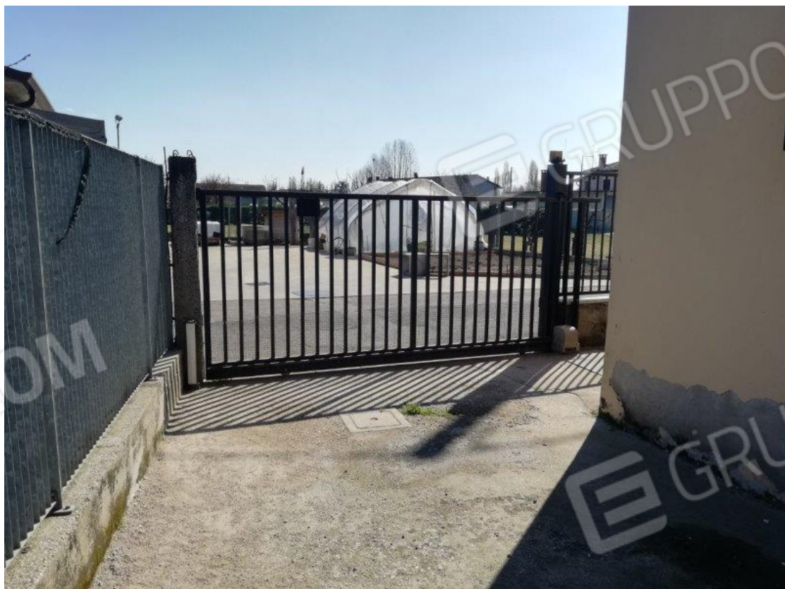
Foto 14: vista uscita su via Zambonina
