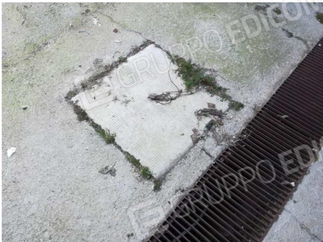
Foto 13: particolare smaltimento acqua
