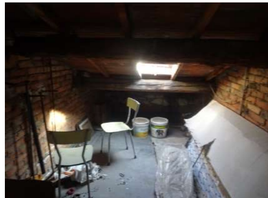
vista interno soffitta
