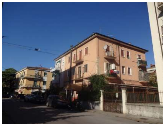
Facciata con esposizione ad est
