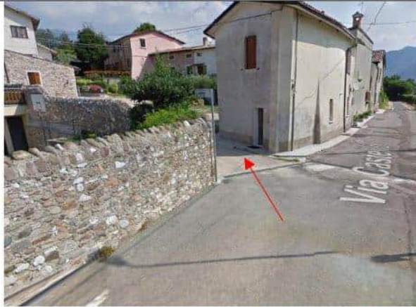
Figura 17: ripresa fotografica dell'ingresso dalla pubblica via
