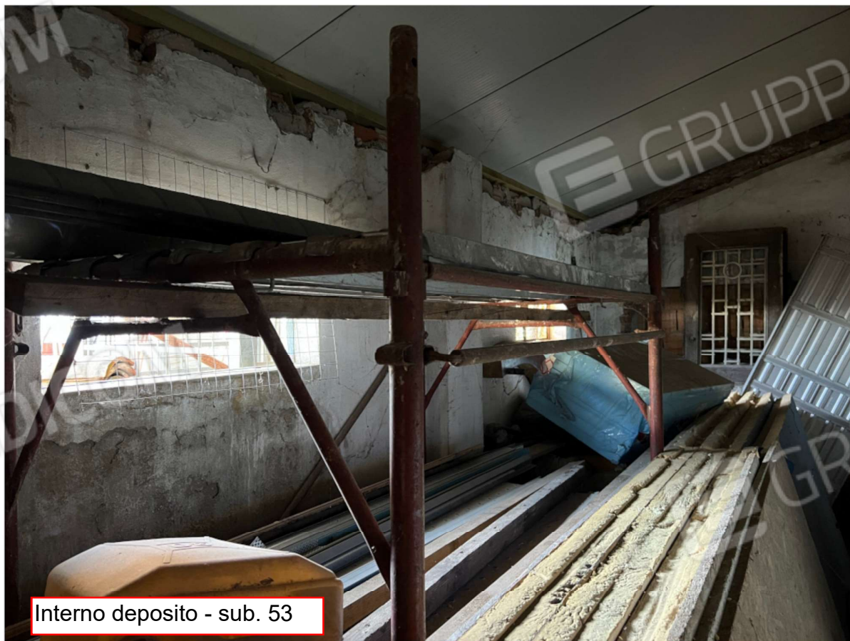
Interno deposito - sub. 53
