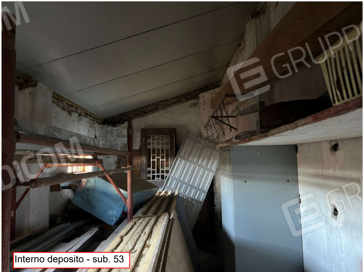
Ingresso deposito - sub. 53
