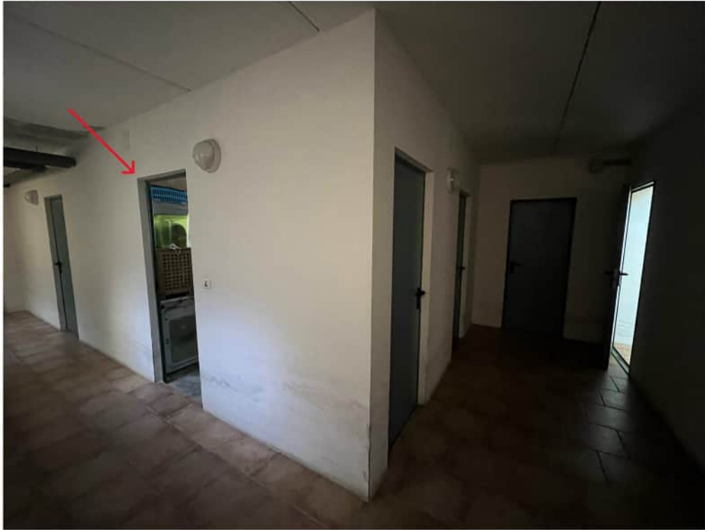
Accesso al garage
