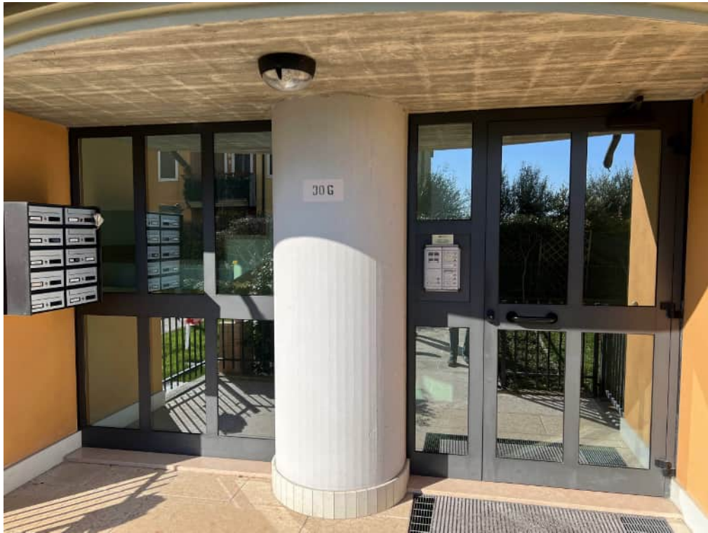
Porta ingresso al complesso
