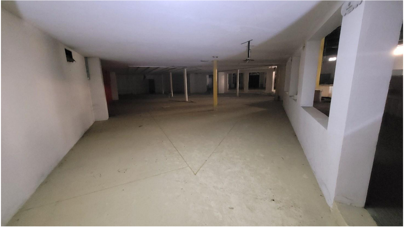
Locale al piano quota cortile
