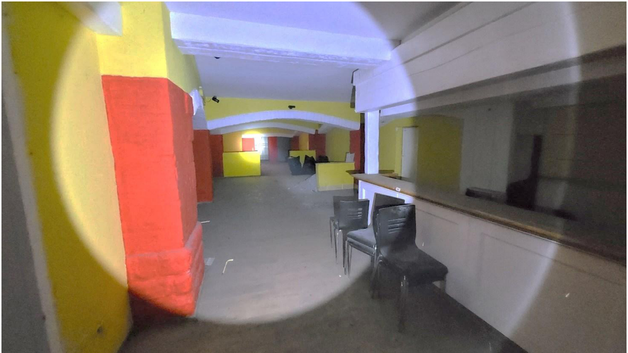
Locale al piano quota cortile
