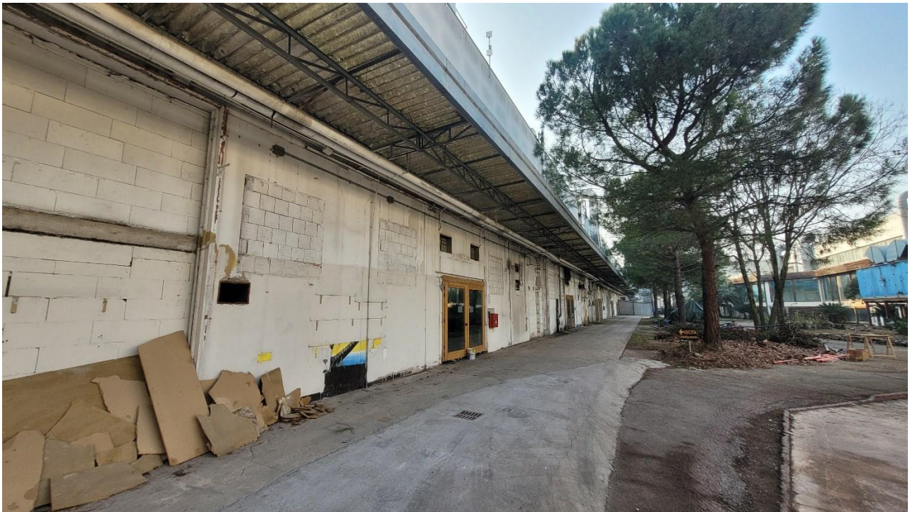
Vista del piano interrato dal cortile interno
