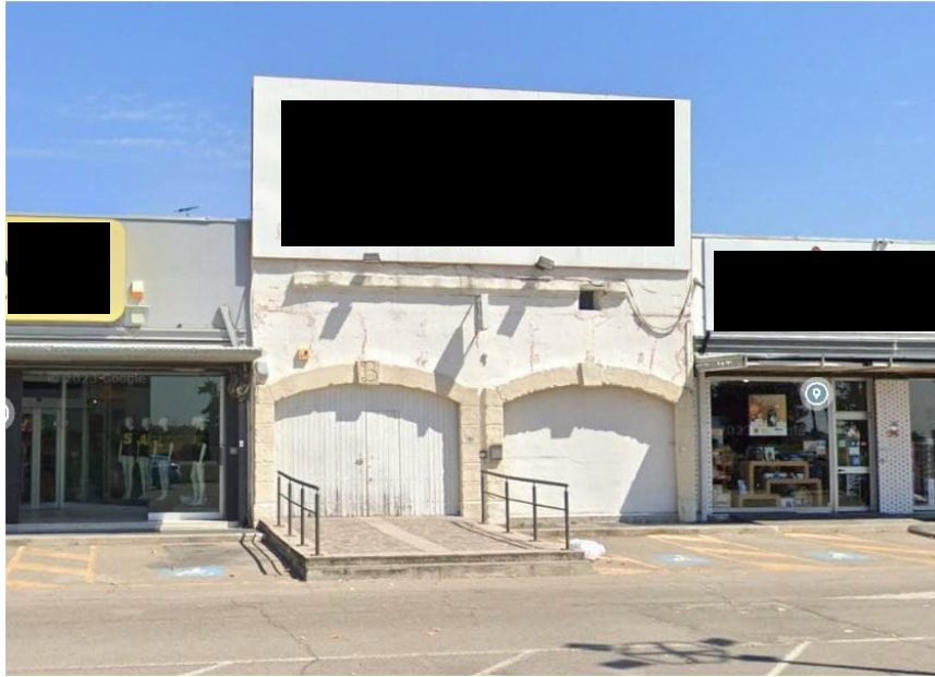
Ingresso al piano terra visto dal piazzale antistante
