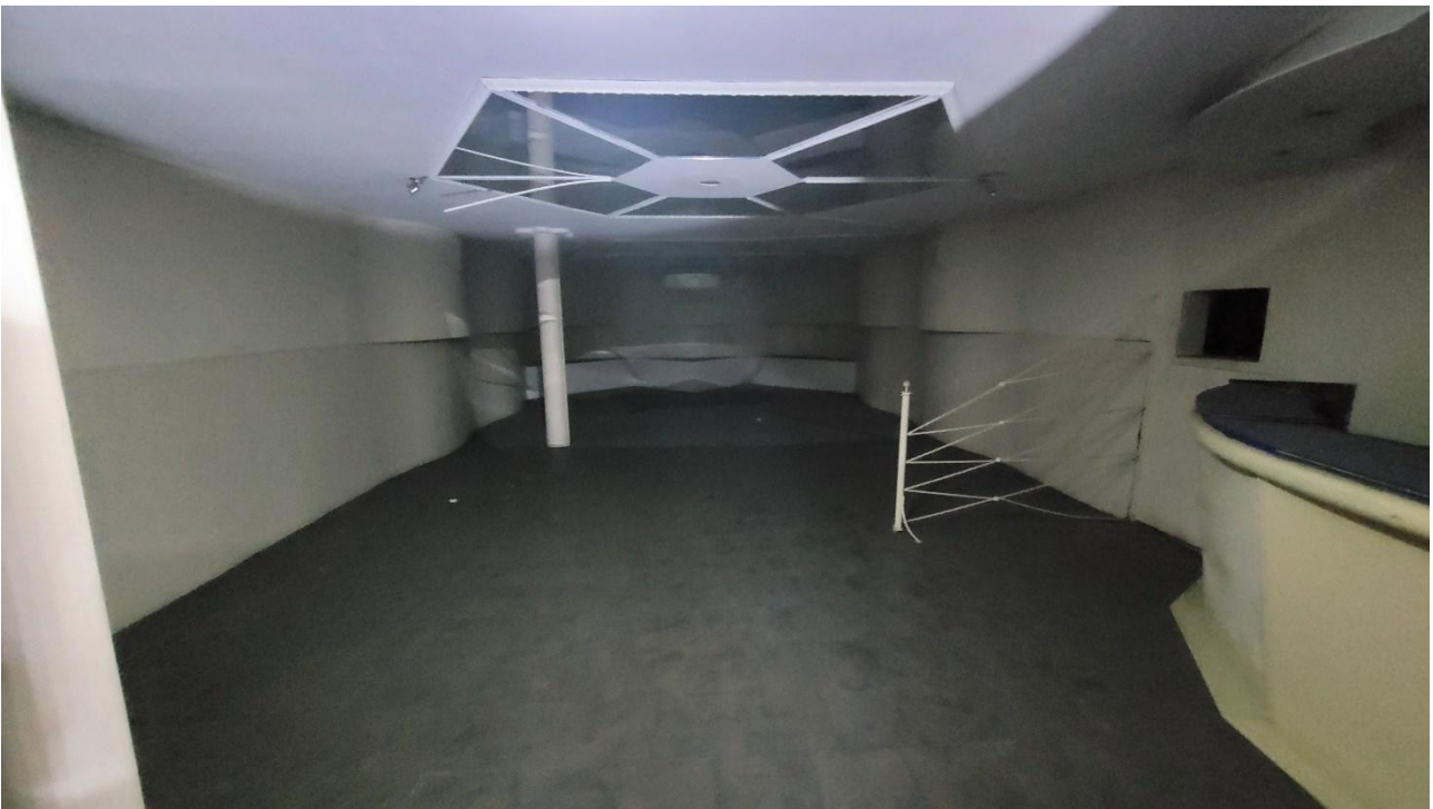
Locale al piano quota cortile
