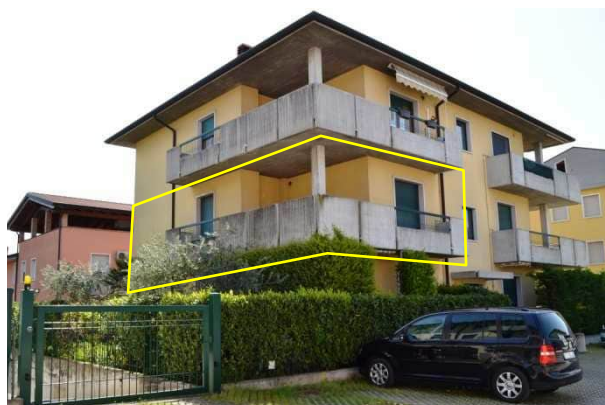
foto 8 - prospetti nord e ovest fronte strada del condominio La Primula in via Vicenza 1/C, Caldiero
