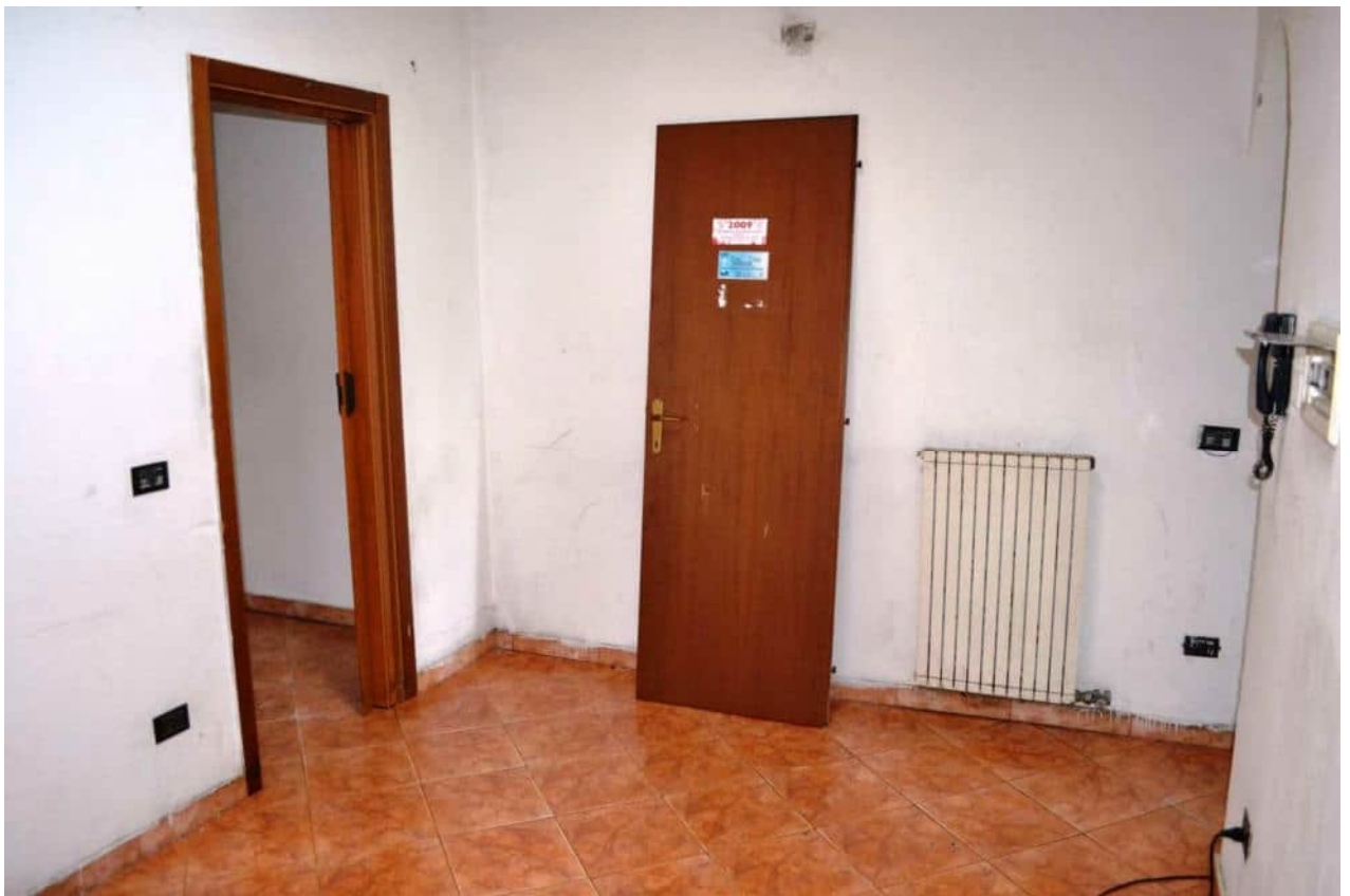
foto 27 – ABITAZIONE m.n. 533 sub 2, piano 2° sottotetto - vista dell'interno dell'ingresso dal vano scala del monolocale spartito a piano 2° sottotetto, con la porta del locale ( camera in catasto) ricavato a nord fronte strada a sinistra della foto, di fronte all'ingresso dalla scala e dell'angolo cottura che s'intravede a destra della foto e tetto in falda in travi di legno e tavolette di laterizio
