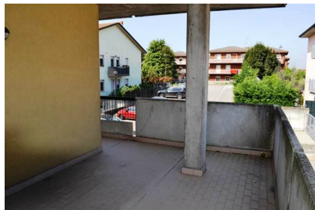
foto 35 - l'ampio terrazzo dell'appartamento visto da est, affiancato al soggiorno/cucina
