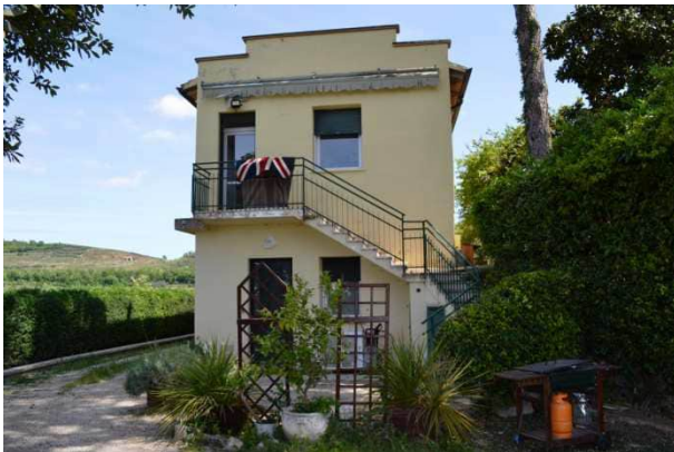
foto 23 - fianco sud con accessi sia a piano terra che a piano primo della casa colonica
