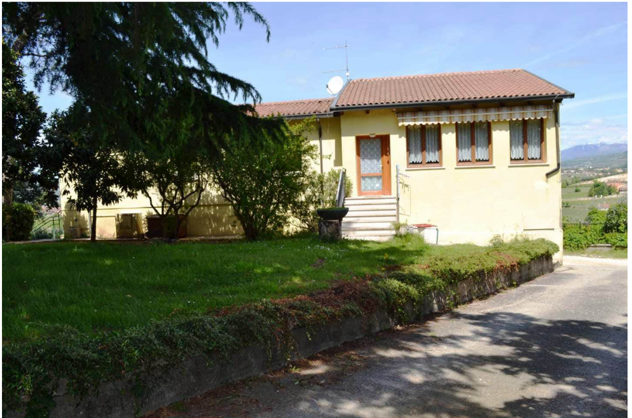
foto 22 – villa con dipendenze, parco e oliveto, CASA COLONICA (vista da sud sul parco della villa) - la casa colonica a nord est della villa è elevata a due piani f.t. oltre a scantinato, col la parte ovest (dietro la pianta nella foto) usata come abitazione autonoma e la parte est a destra della foto col piano 1° adattato senza formalità come monolocale con accessori (angolo cottura e bagno)
