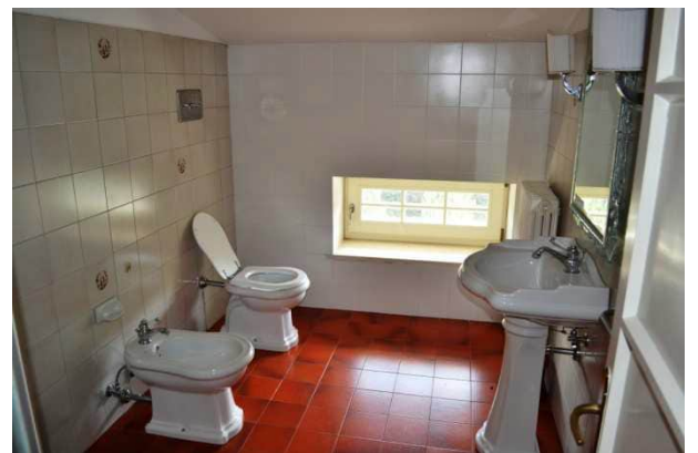
foto 19 - scorcio del bagno sottotetto adiacente alla stanza nord est
