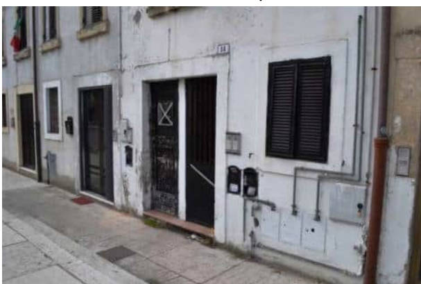
foto 14 - scorcio dell'ingresso spartito con le adduzioni del gas a ciascuno dei piani
