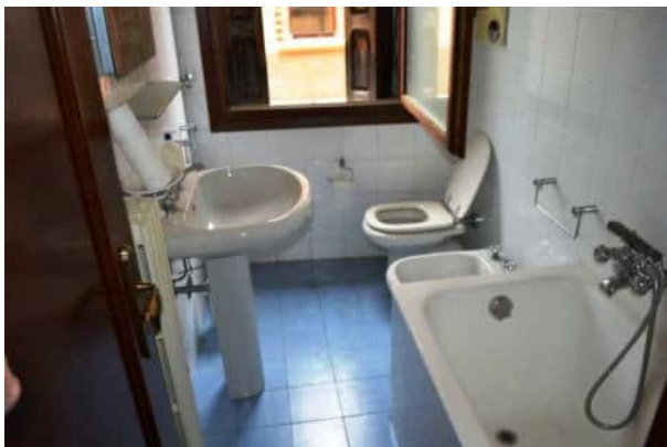
foto 10 - vista dall'ingresso del bagno con pavimento e pareti rivestiti in ceramica
