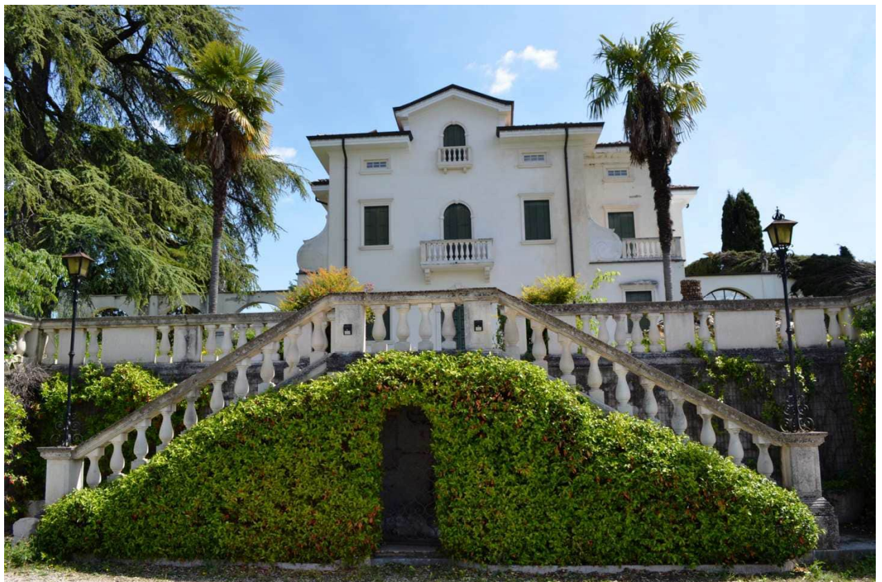
foto 1 – villa con dipendenze, parco e oliveto, VILLA (vista da ovest sul vialetto interno) - la facciata della villa ristrutturata in stile '700 su tre piani f.t. con 9 stanze con accessori e pertinenze, con casa colonica e magazzino e con parco e oliveto recintati di m 2 27.529 catastali in fregio a via Zanella con ingresso al civ. 19 a Colognola ai Colli, è rivolta verso ovest in sommità della collina
