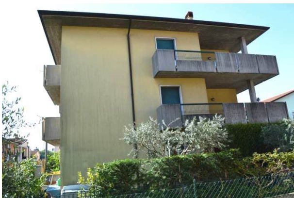
foto 34 - prospetto nord del condominio la Primula visto dal lotto edificato confinante
