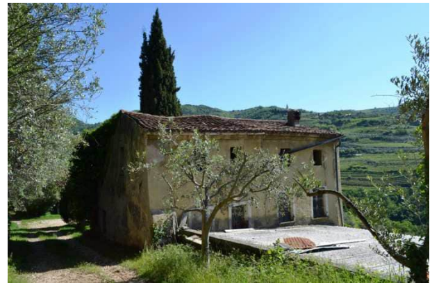
foto 27 - visto da sud ovest del rustico a tre piani f.t. con la tettoia (da demolire in atti)
