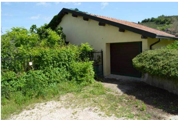
foto 25 - prospetto sud d'ingresso del magazzino rustico a nord ovest della villa
