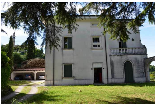
foto 3 - fianco nord con le porte del sottoscala e d'ingresso e a est la tettoia nel cortile
