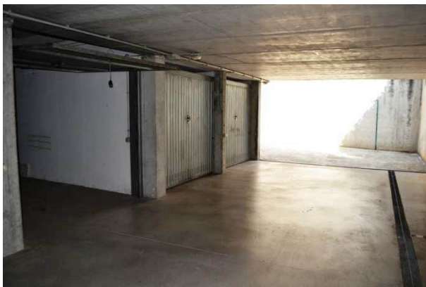
foto 43 - vista da sud del tratto finale della corsia di manovra con l'autorimessa da stimare
