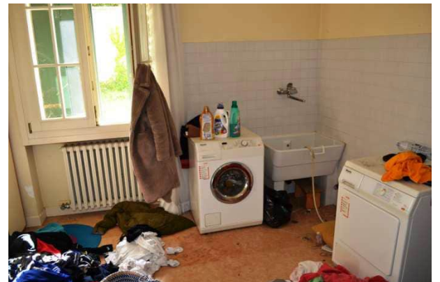
foto 11 - scorcio della lavanderia vicino al bagno a piano terra con finestra sul cortile a est
