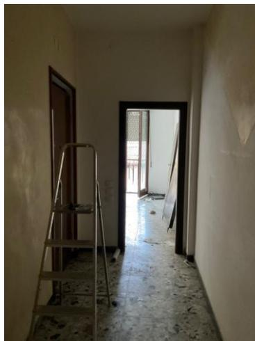
Le pareti interne sono intonacate e tinteggiate, versano in mediocre stato di conservazione; tuttavia non appaiono dissesti, tracce di umidità o muffe.
