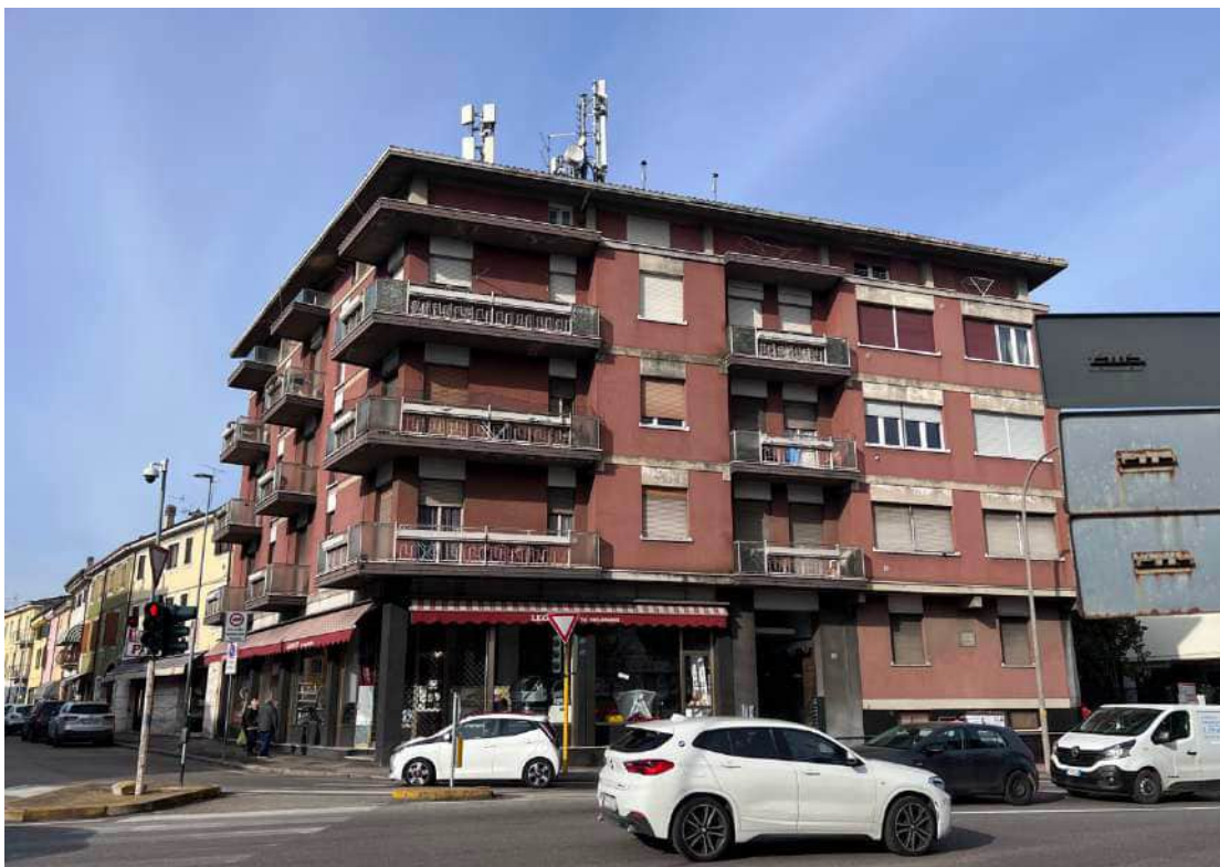
FOTO 1 - Fronte Est/sud, via Albere incrocio via Mantovana
