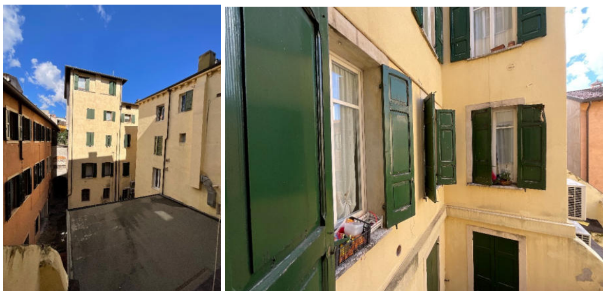
Vista Edifici adiacenti con affaccio su cortile interno
