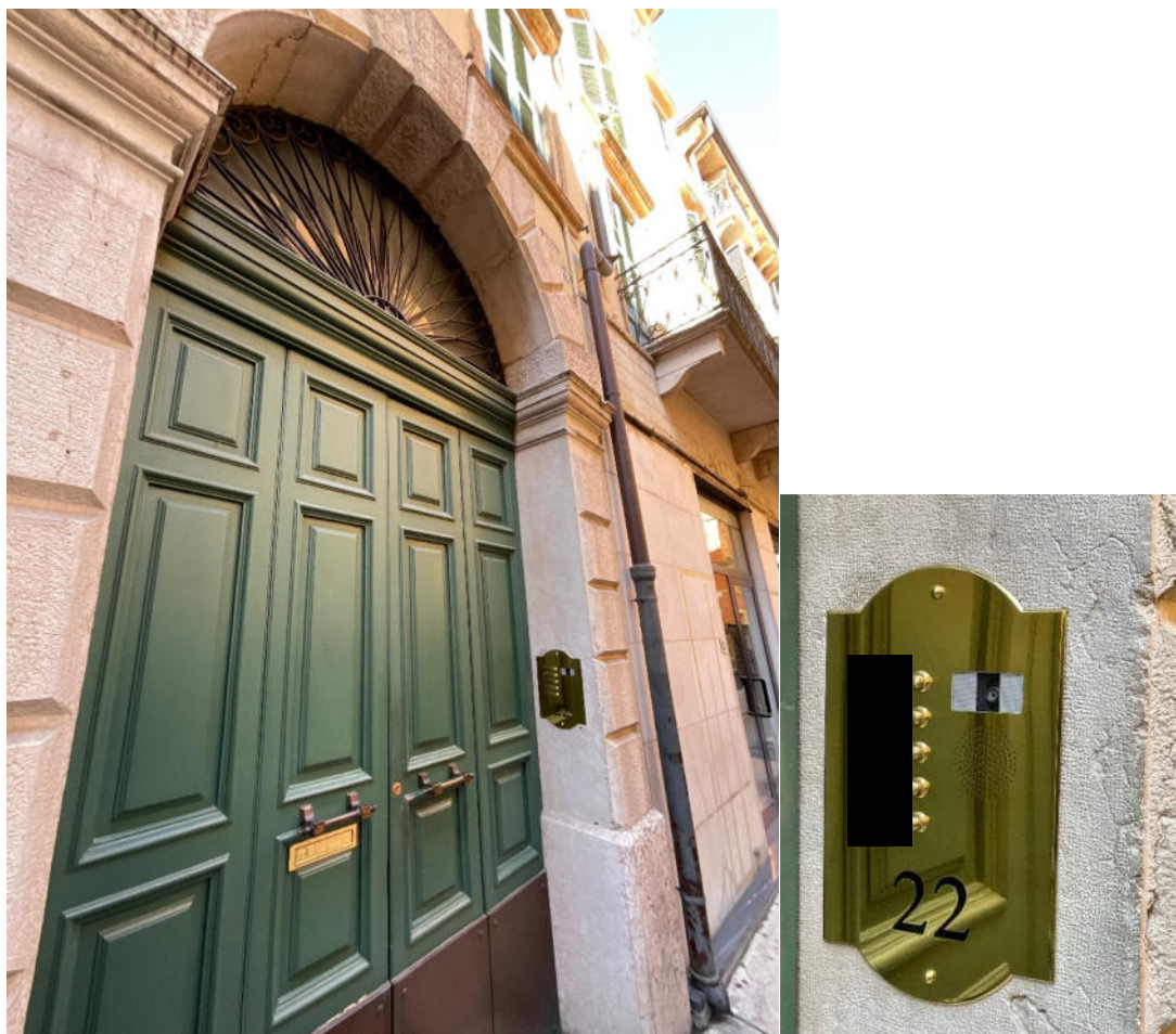
Vista Portone d'ingresso all'edificio con affaccio su Via Pellicciai
