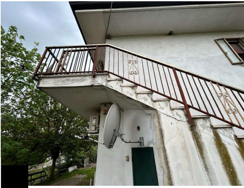
Figura 5: dettaglio scala di accesso
