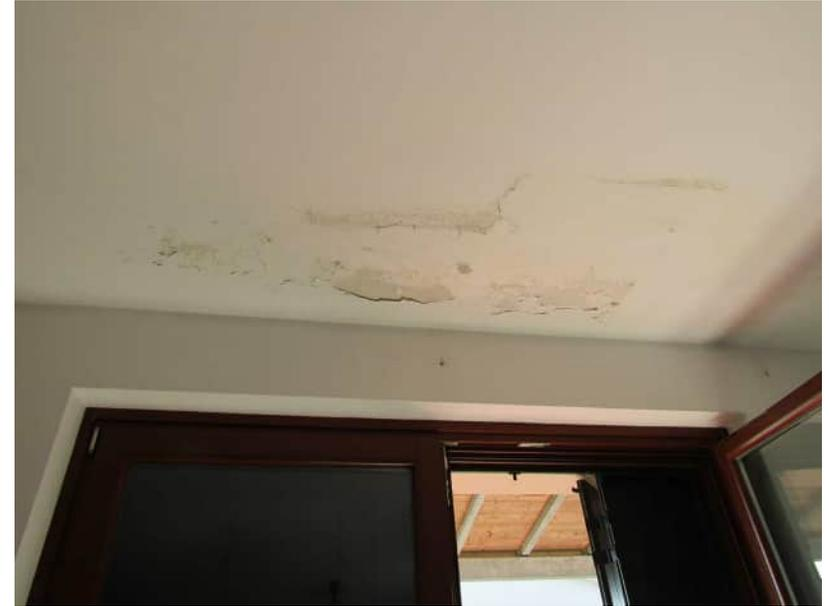
Foto 10: dettaglio delle infiltrazioni del soggiorno
