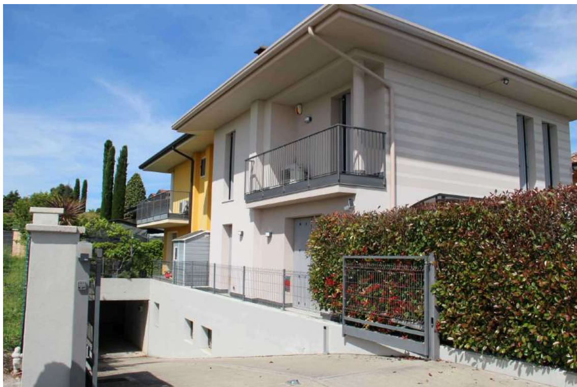
2. Vista dei prospetti Sud ed Est dell'edificio e della rampa comune
