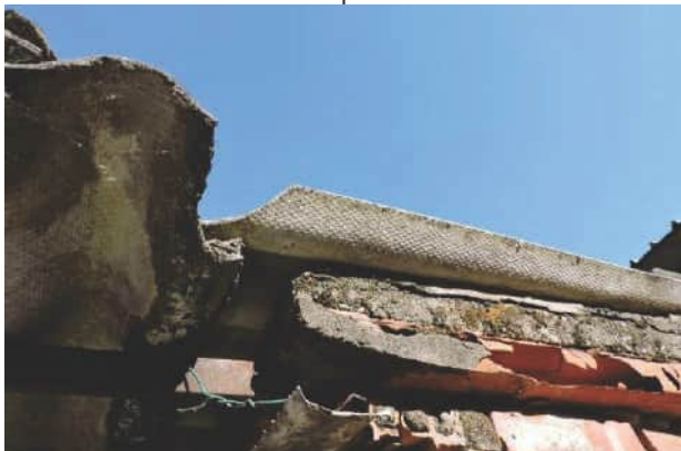
Foto 22 Lastre di copertura in cemento amianto
