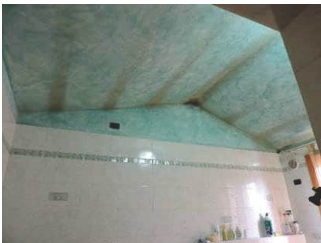
Foto 17 Soffitto del bagno con fenomeni di muffa
