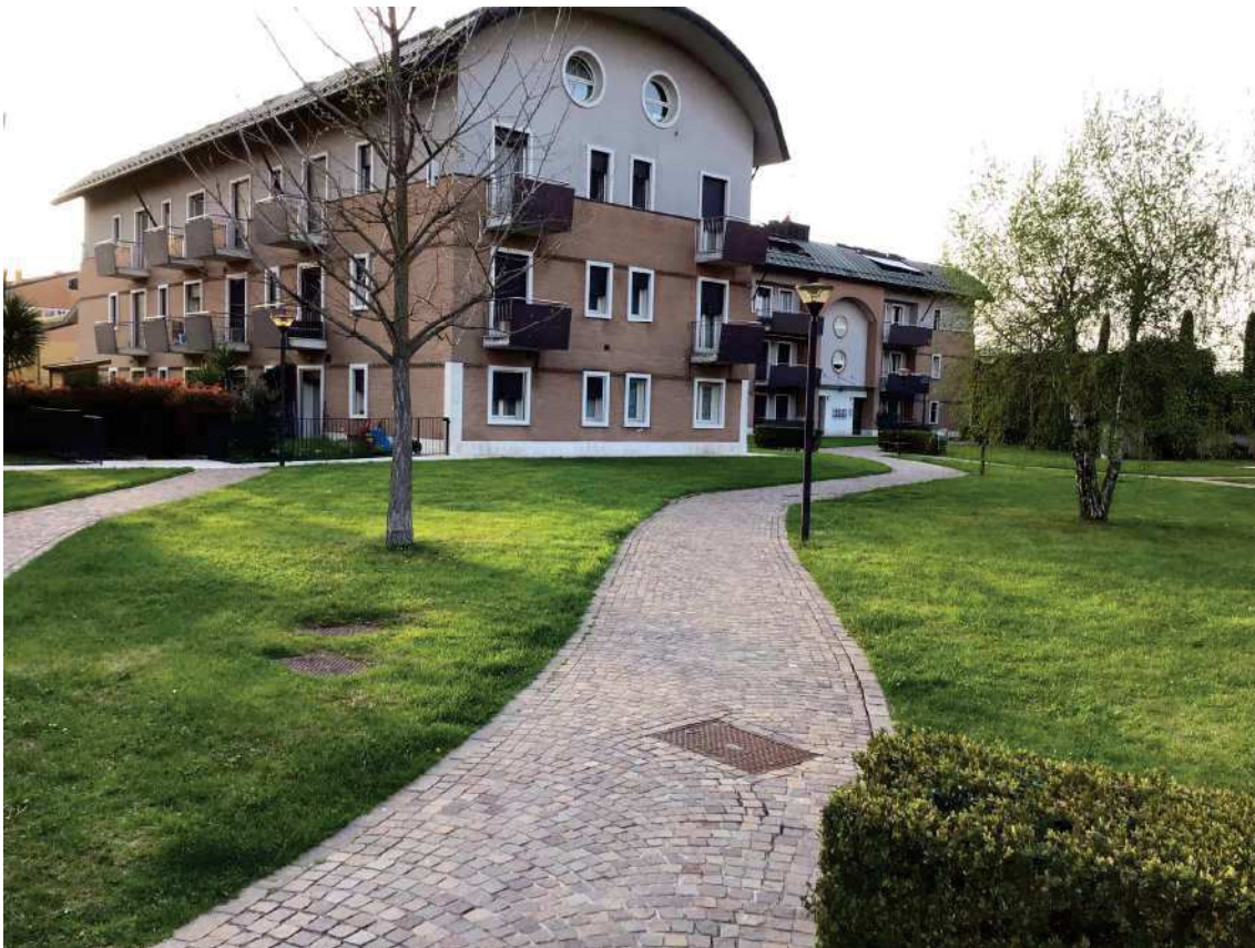
VISTA DAL PARCO
