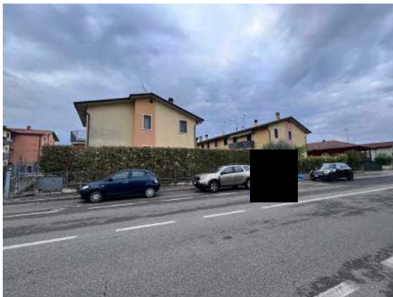
Foto 1 – Fronte nord - Ingresso da Via Tamagni
