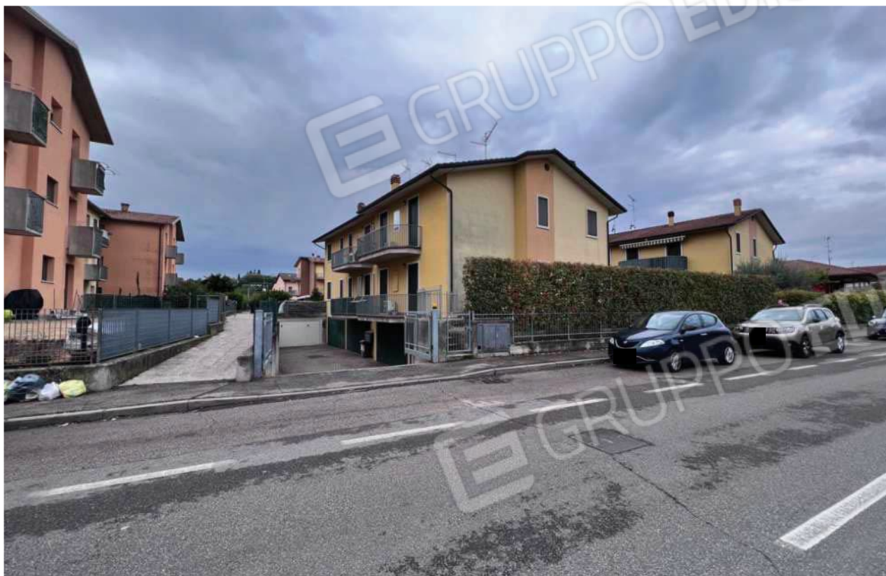
FOTO 1 - Fronte Nord, ingresso su via Tamagni
