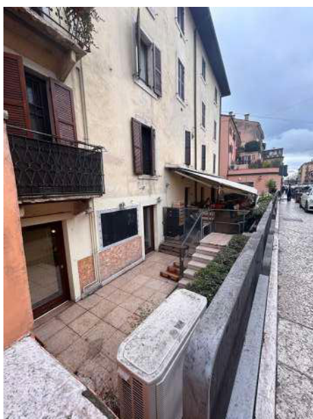
Area esterna di proprietà - lato ovest
