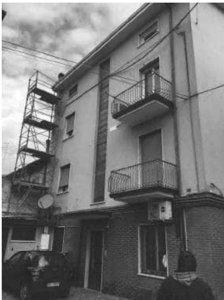
4. Il Fabbricato sul lato ovest
