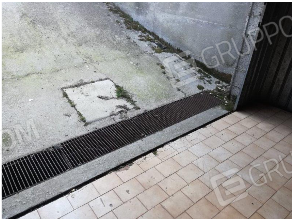
Foto 10: griglia e pozzetto perdente
