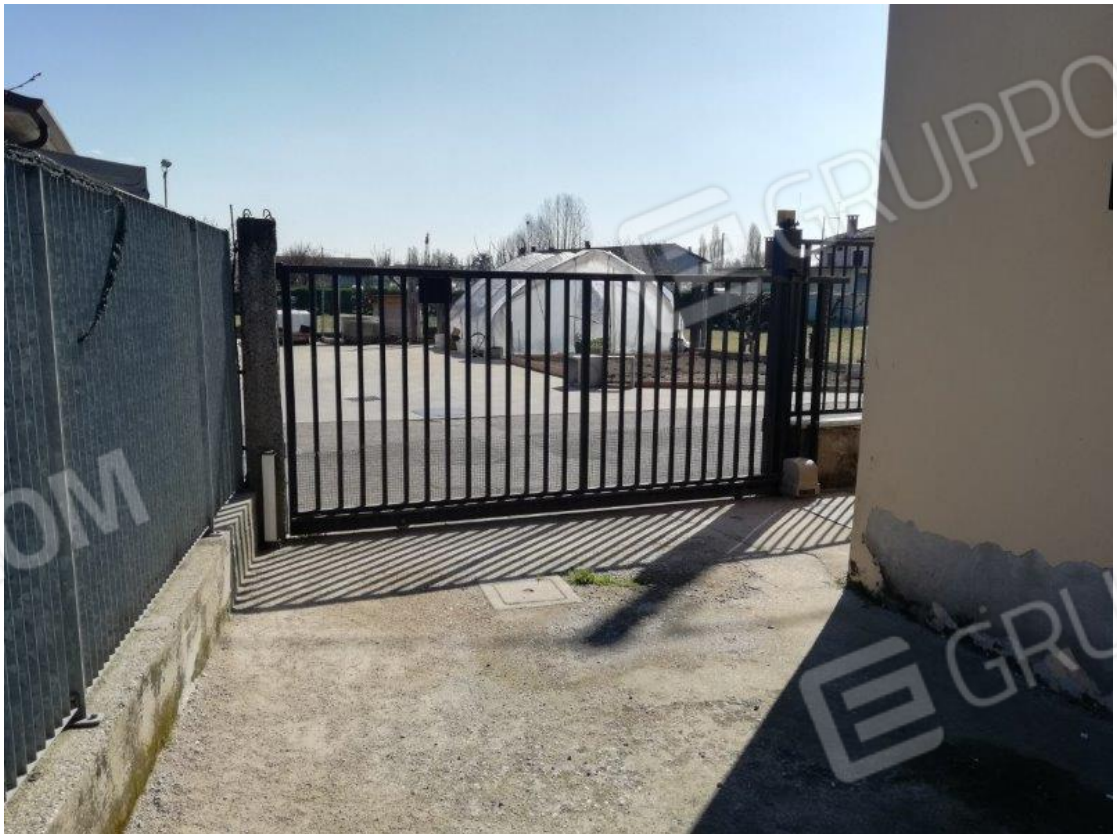
Foto 14: vista uscita su via Zambonina
