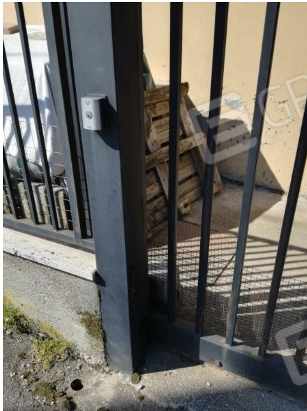
Foto 22: particolare chiave motorizzazione cancello
