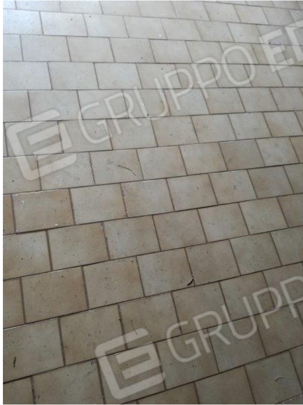
Foto 17: particolare pavimentazione in ceramica
