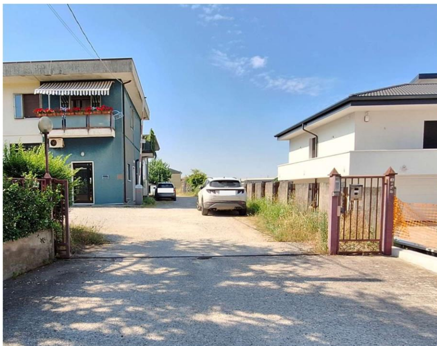
Figura 14: ripresa fotografica del cancello carraio che risulta installato sulla particella 1222 sub 3
