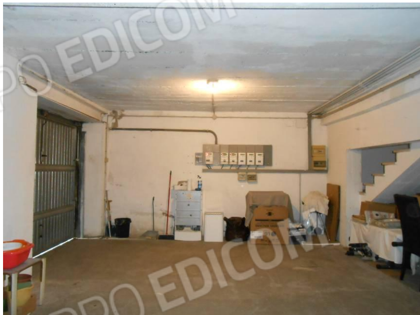
Piano Interrato, area comune
