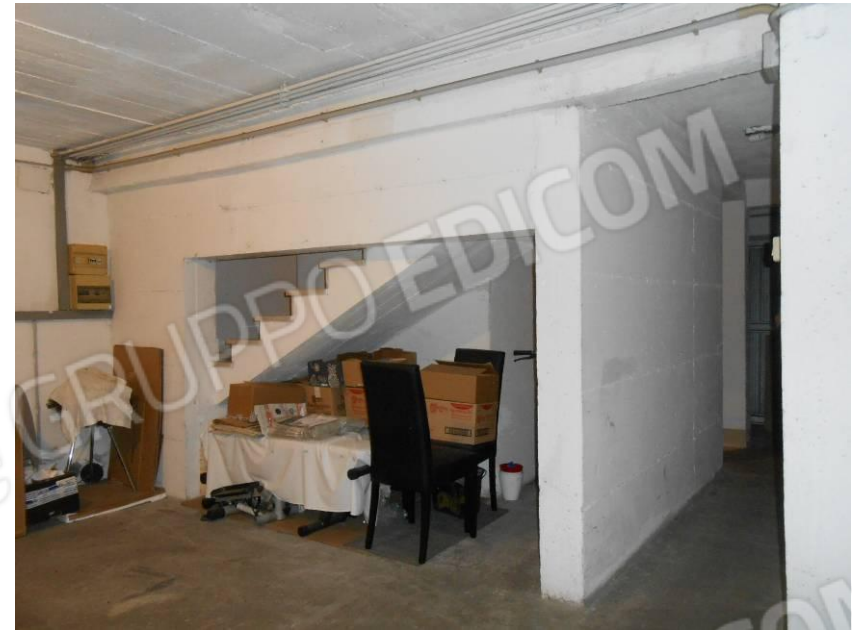
Piano Interrato, area comune
