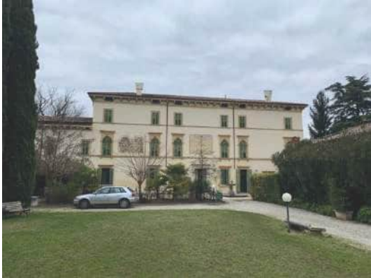
Vista del prospetto sud
