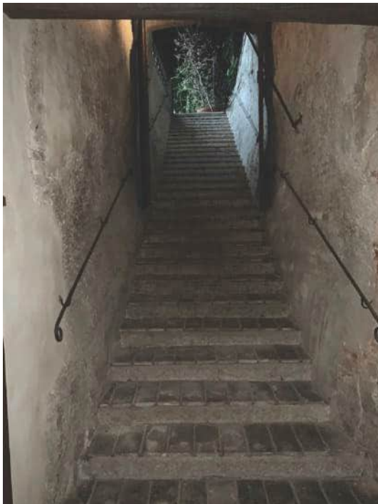
Vista della scala di accesso
