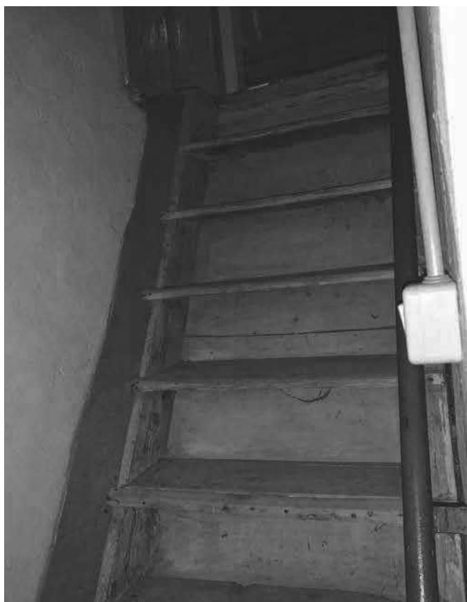
25. vano scala da P.T a P.1
