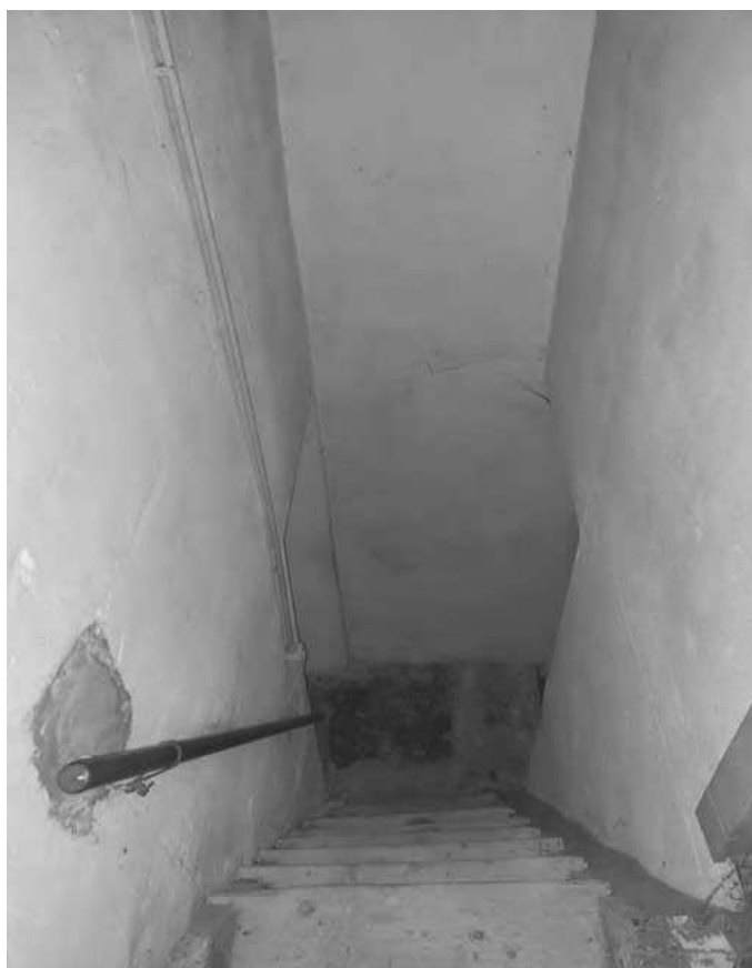
26. vano scala da P.1 a P.T
