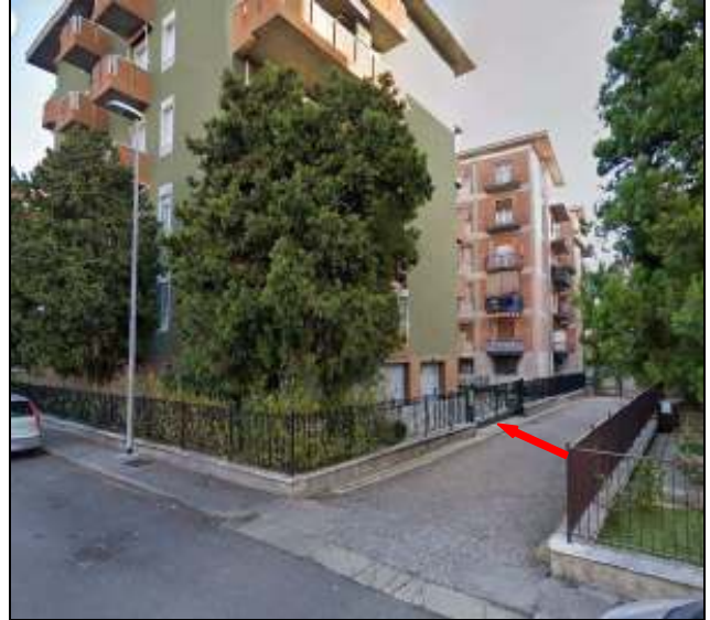
Ingresso da via Toniolo sul retro dell'edificio
