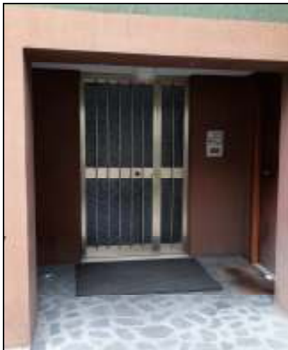
Ingresso al vano scala
