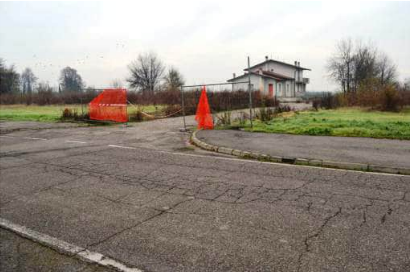
foto 4 - Scorcio dell'accesso fronte strada del PUA ORTI in via Don R. Tressino a Orti di Bonavigo
