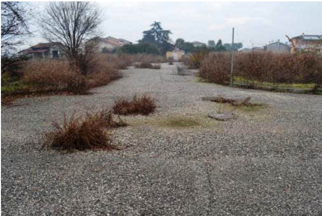
foto 14 - Vista del tratto est della strada interna (cieca con manovra) del PUA ORTI, visto da ovest
