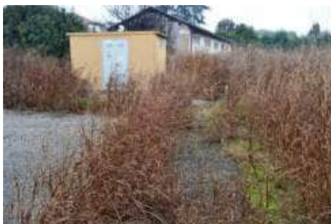
foto 18 - Scorcio della cabina elettrica sul m.n. 275
