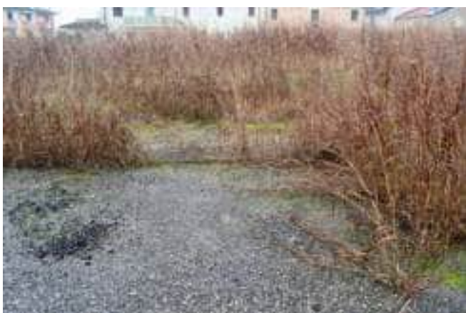
foto 17 - Particolare del marciapiede stradale sud
