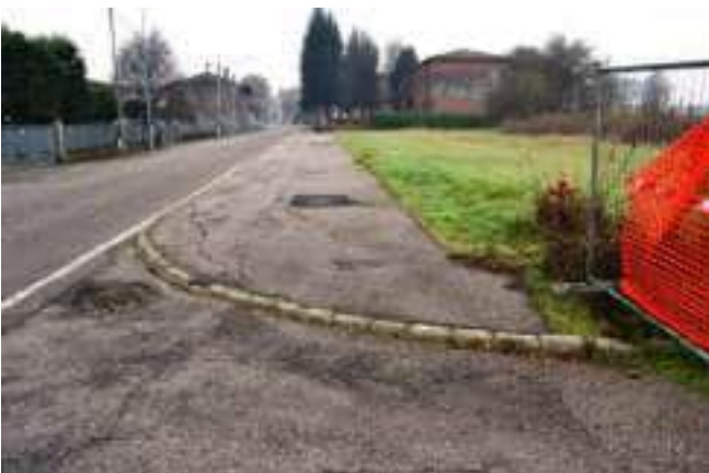
foto 7 - Scorcio del marciapiede con pista ciclabile
