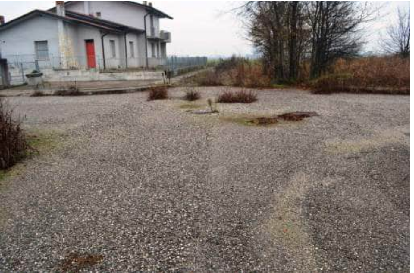
foto 9 - Scorcio dell'incrocio stradale interno del PUA ORTI in via Don R. Tressino - visto da sud
