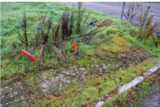
foto 22 - Particolare delle derivazioni degli impianti
