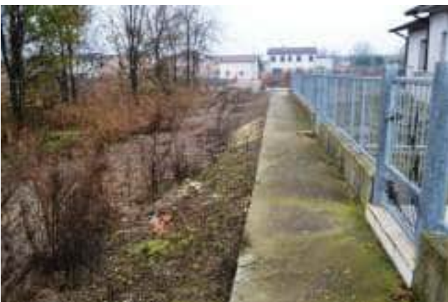
foto 12 - Scorcio da nord del tratto di "futura viabilità"
