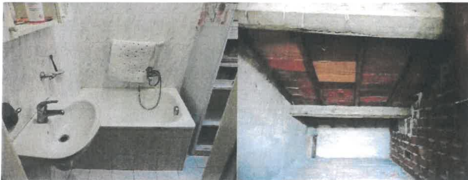
APPARTAMENTO SUB 3: BAGNO
