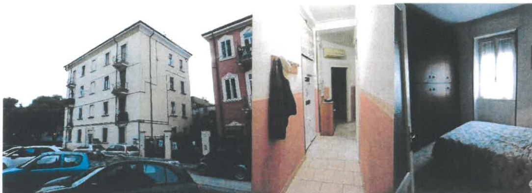
CONDOMINIO VIA GUARINO 1°
