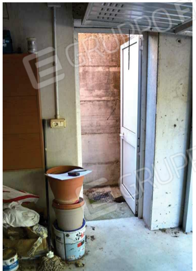
foto 20 - porta verso scala esterna di collegamento
