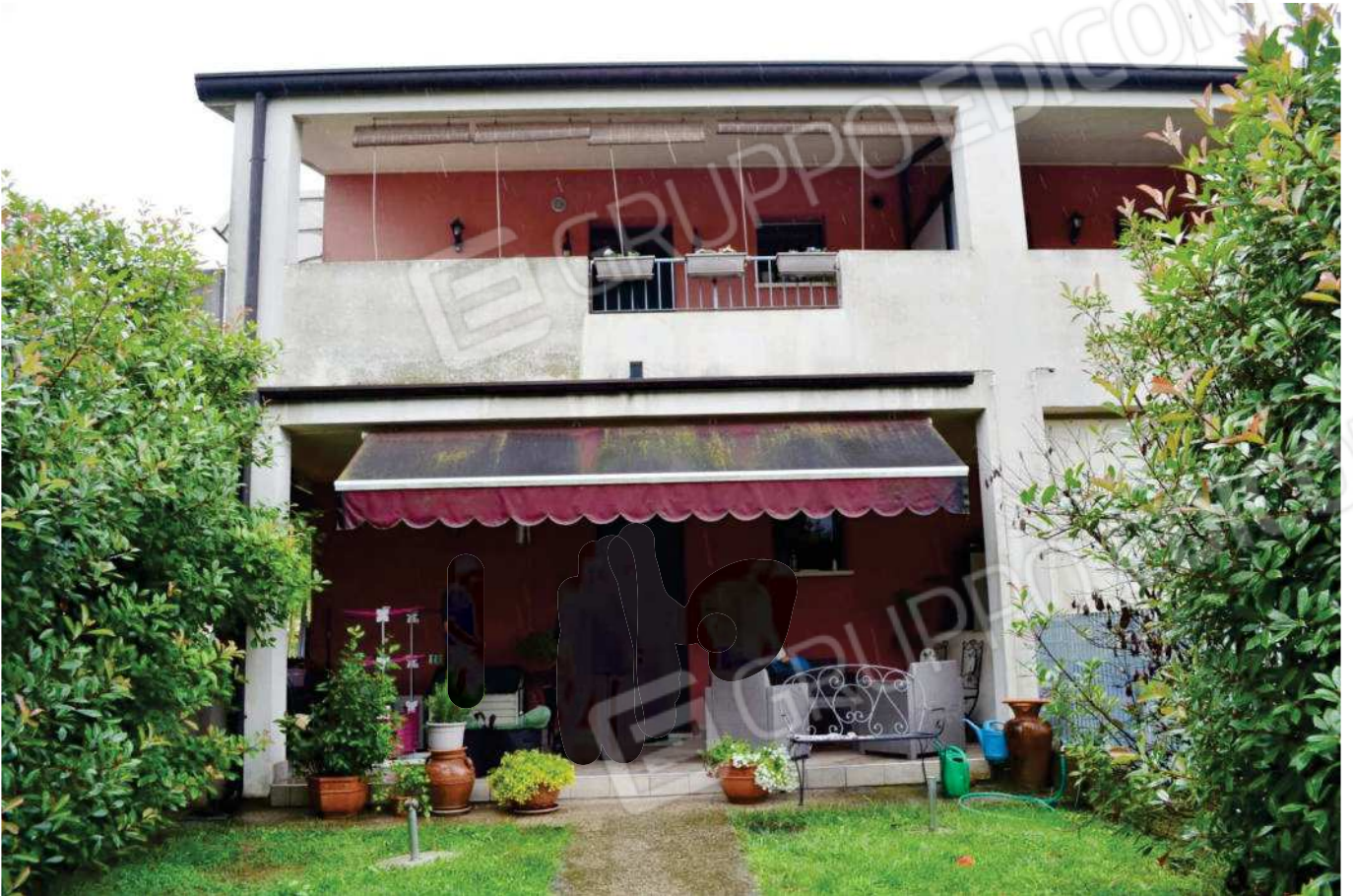
foto 4 - Scorcio del prospetto nord dell'appartamento a piano terra in via BONINO n. 7 col giardino esclusivo
