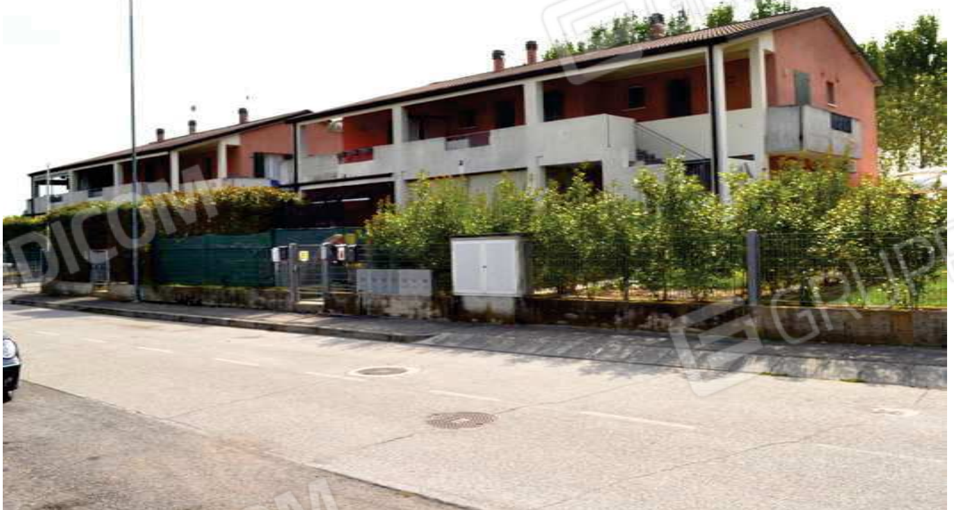
foto 3 - Prospetto nord dell'edificio in via M. BONINO n. 7/9 a Cerea, visto da nord ovest sulla strada
