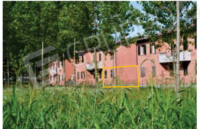
foto 6 - Prospetti sud degli edifici di via Bonino
