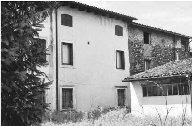
foto 5 - vista da nord est del prospetto nord sul retro dell'abitazione (centro foto) in località Le Ché, con la parete esterna sottogronda del piano secondo – zona notte con tetto in falda – con vistosa igrofania per percolazione all'imposta della falda per l'inadeguato presidio della grondaia e copertura
